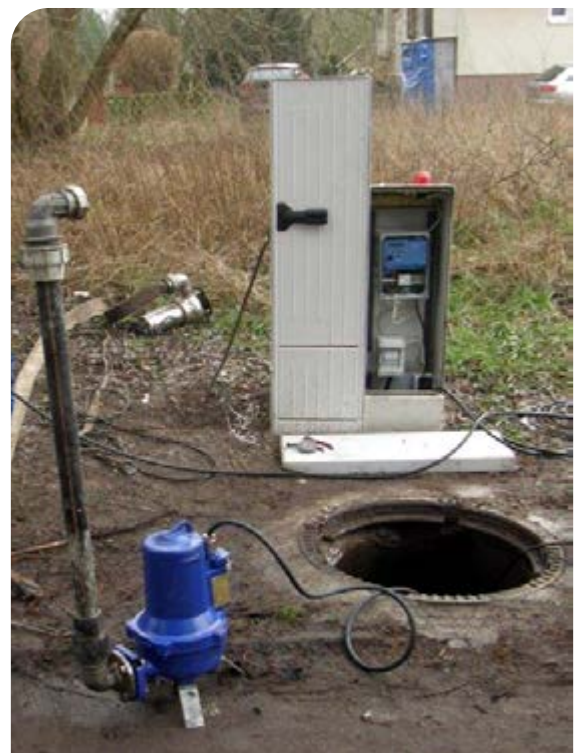
Installation einer Abwasserhebeanlage
