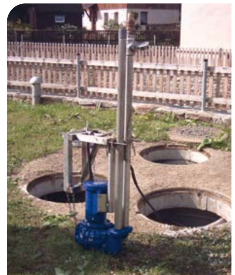
Installation eines TMV
