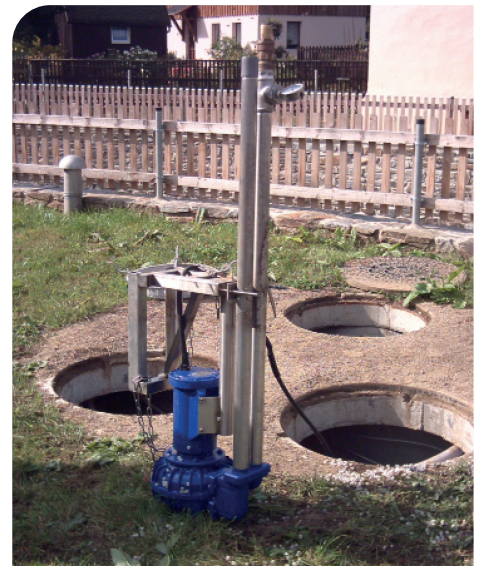
Installation eines TMV
