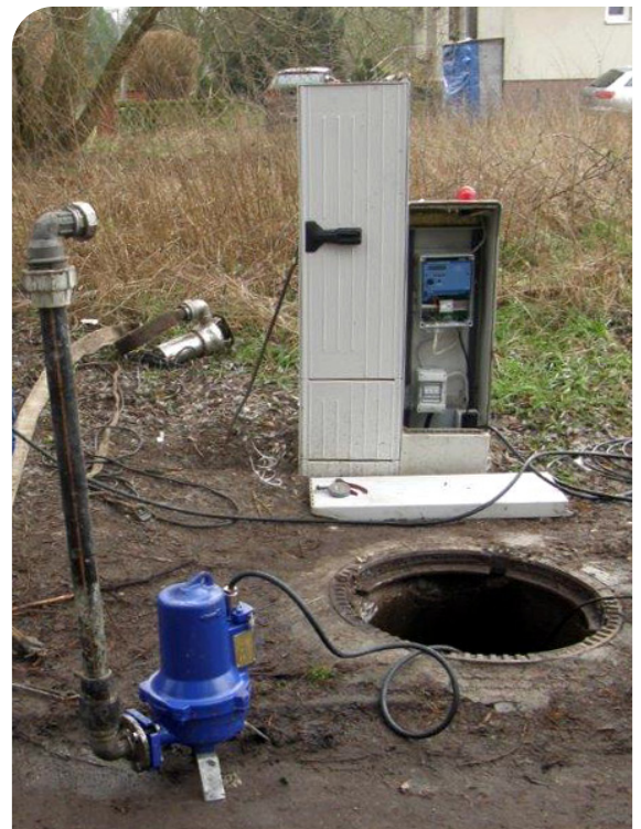
Installation einer Abwasserhebeanlage
